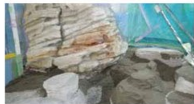
水槽に岩を入れ、水に沈む部分にモルタルを詰めるところ。
