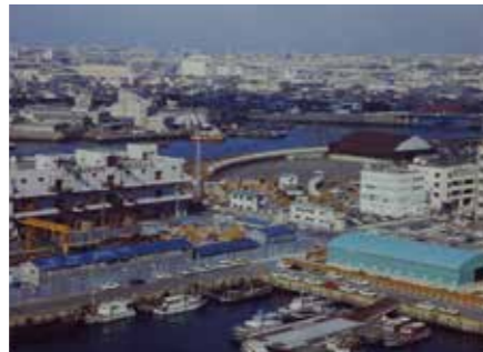
水族館建設に先立ち設置された 生物保管棟(写真右の緑のテント)。
